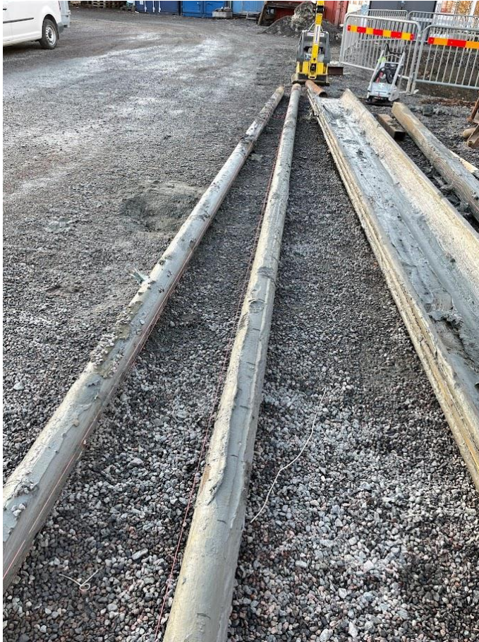
Figur 5-2: Uppdragna cirkulära pålar med murarsnöre
